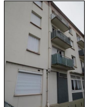
Photo N° 1081 AMIANTE CIMENT - -FACADE ARRIERE Conduits de ventilation Ventilation haute (Fibres- ciment)
