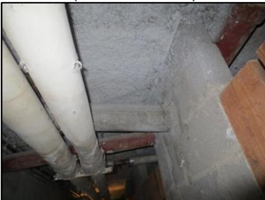
Photo N° 1085 AMIANTE CIMENT - -COULOIRS DE CAVES Conduits de fluide Chute E.U.(Fibres-ciment) X2
